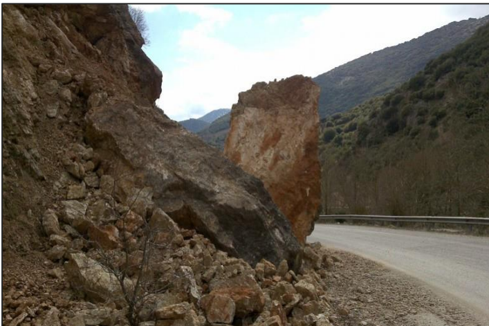
Εικόνα 1: παλιά οδός Κοζάνης-Ιωαννίνων που είναι κλειστή λόγω κατολισθήσεων και χρησιμοποιήθηκαν εκρηκτικοί μηχανισμοί για να θριμματιστούν τα πετρώματα και να ξανα λειτουργήσει [7,8]
