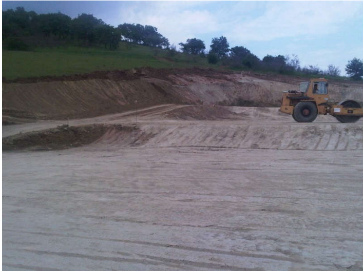
Καθαρισμός & διαμόρφωση περιβάλλοντος χώρου
