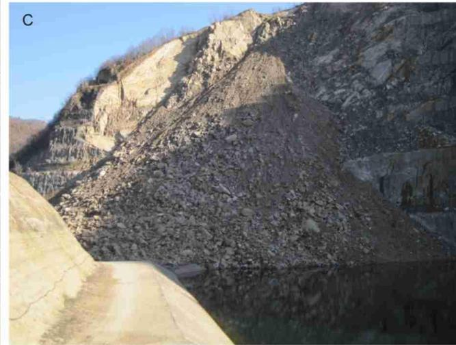
Η αστοχία, όγκου  $330.000\text{m}^3$ , έλαβε χώρα στις 10/2/2008. Πρόκειται για μία σύνθετη αστοχία η οποία έθεσε εκτός λειτουργίας τους υπερχειλιστές του φράγματος.
