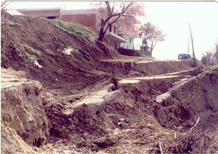
Άποψη ανάντη τμήματος κατολίσθησης όπου διακρίνονται η στέψη, η κύρια κατακρήμνιση, η κεφαλή και η δευτερεύουσα κατακρήμνιση.
