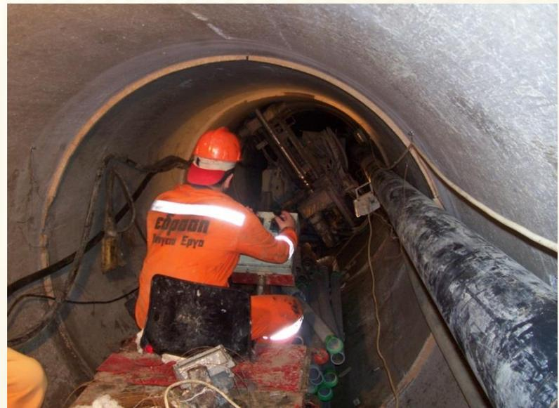
➤ Εγκατάσταση στο εσωτερικό της επένδυσης πλαστικού εγχάρακτου σωλήνα **PVC** με εξωτερικές νευρώσεις και εγκάρσιες σχισμές αποστράγγισης πάχους **t=5mm** και μήκους **L=5-6mm**.
