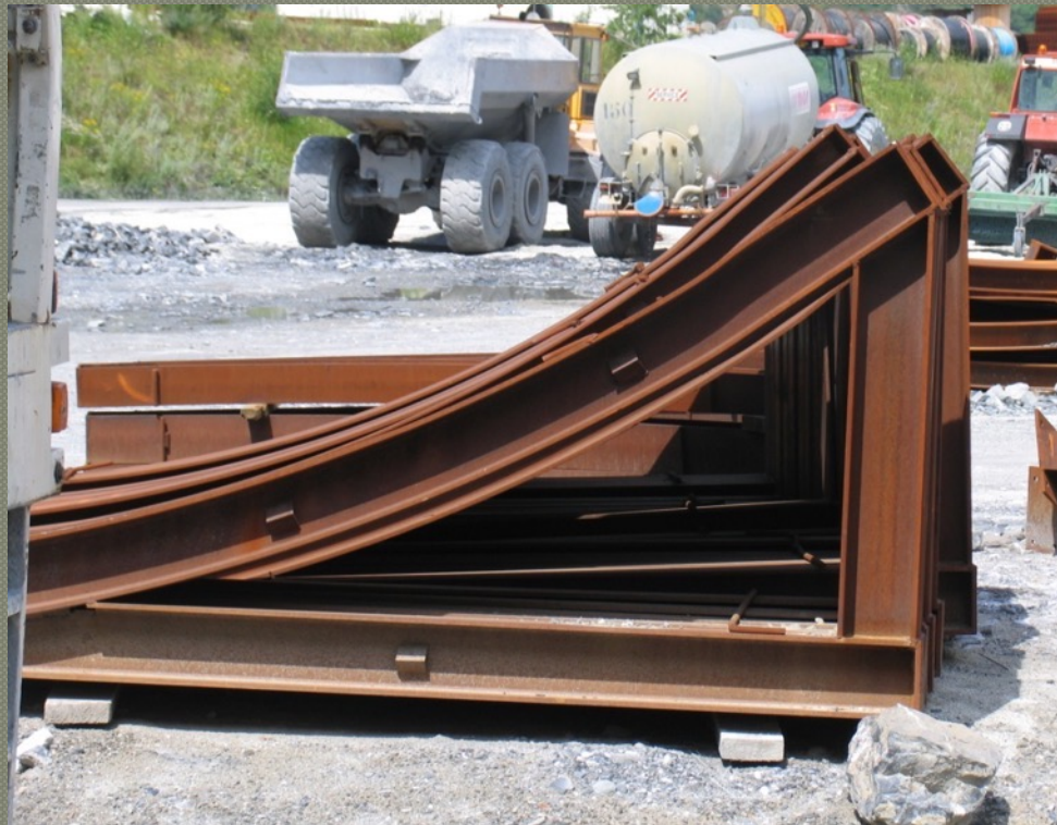
Πλαίσιο με ελεφαντοπόδαρο (ευρεία διατομή στη βάση)
