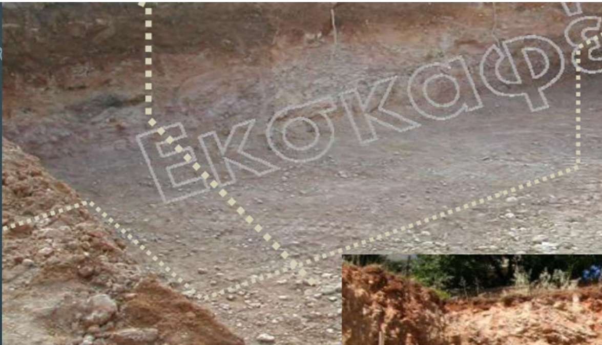
Σκάμμα με κατακόρυφες εξοκαφές περιμετρικά (Σχηματική απεικόνιση τομών εξοκαφής)
