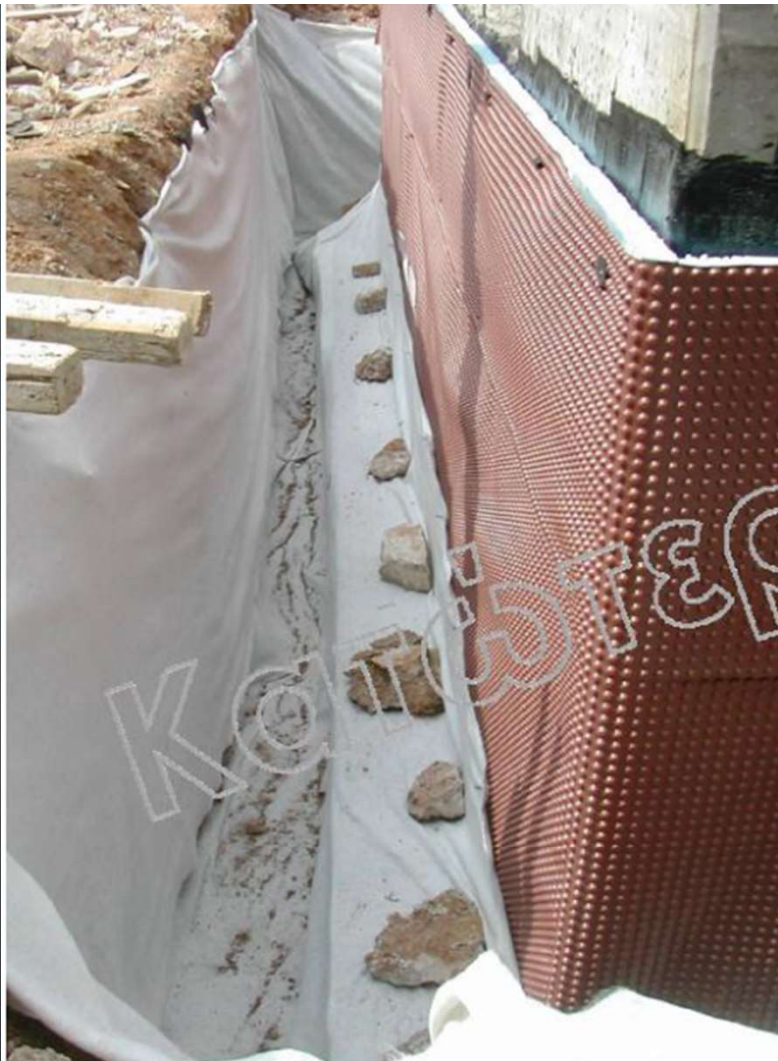
Επικάλυψη κατώτερης στάθμης και επιφάνειας σκάμματος με γεωύφασμα
