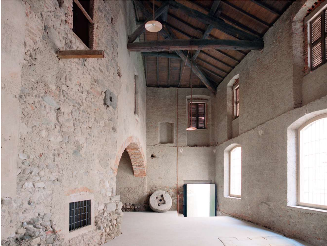
Ανακαίνιση πέτρινου κτιρίου, Montenevchia, Ιταλία 150 m 2 , 2024
