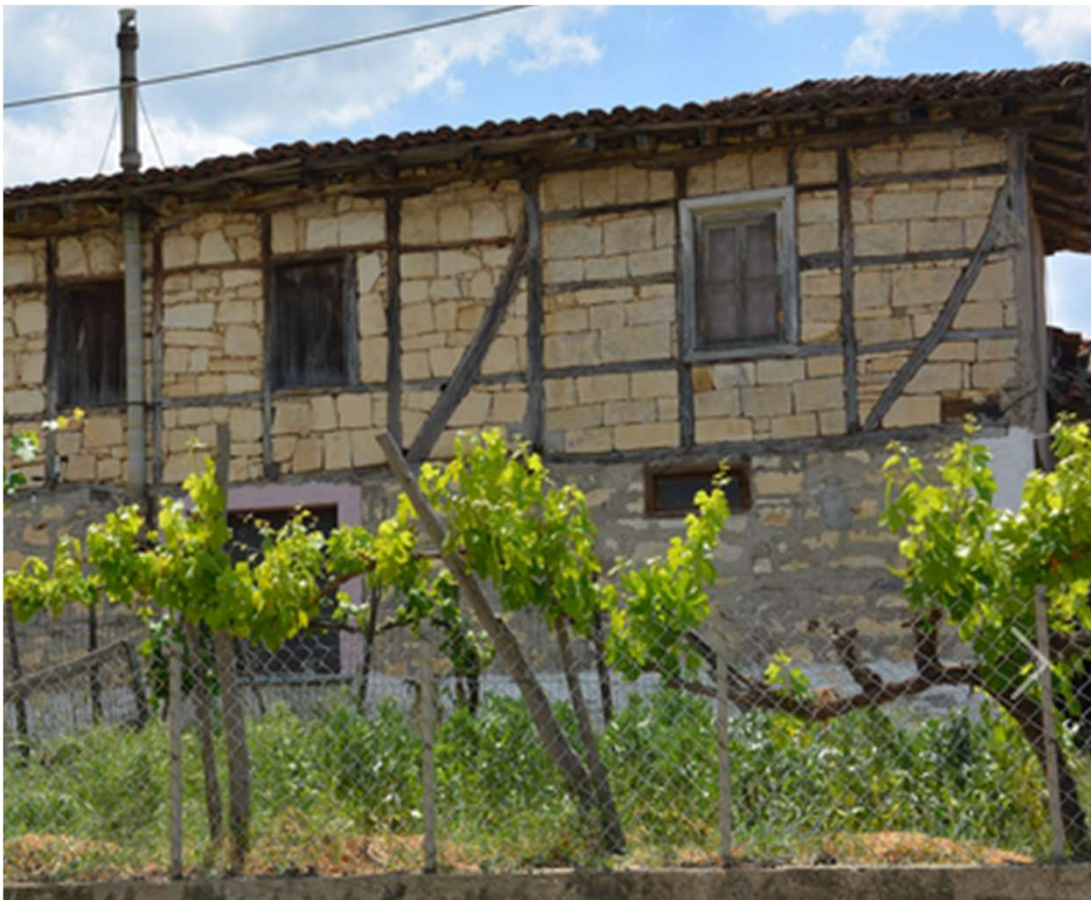
Εικ. Τυπικό κτίριο κατοικίας στους Μεταξάδες Ν. Έβρου. σύνδεση ξυλοδεσιών με τον τοπικό λίθο
