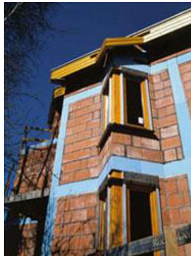
Στοιχεία από οπλισμένο σκυρόδεμα
