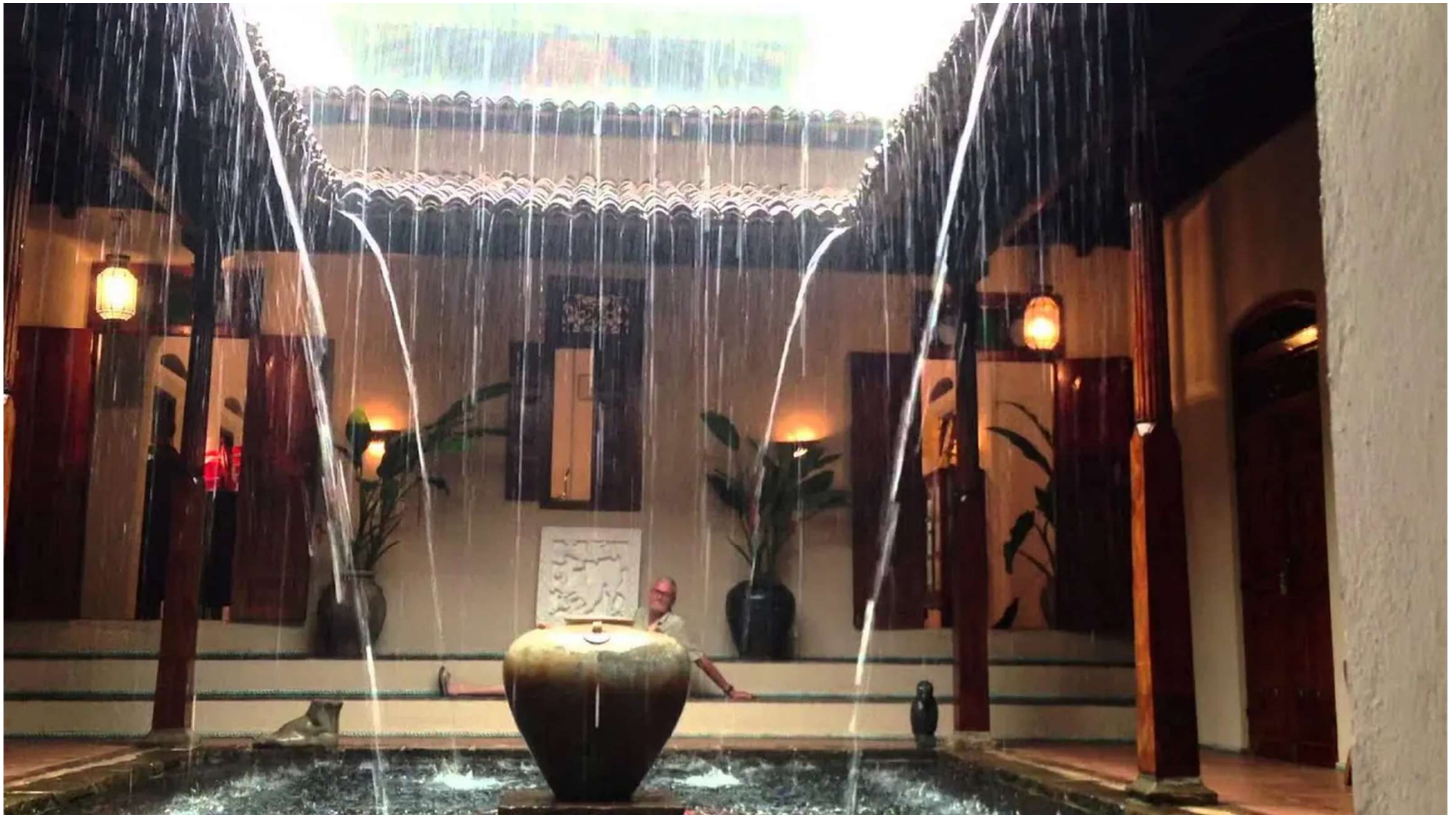
©Youtube,, https://www.re-thinkingthefuture.com/city-and-architecture/a3702-principles-of-rain-drainage-in-architecture/ Αίθριο Κατοκίας, Κεράλα της Ινδίας. Χρησιμοποιούν τις κλίσεις στέγης για να συγκεντρώσουν τα νερά της βροχής.
