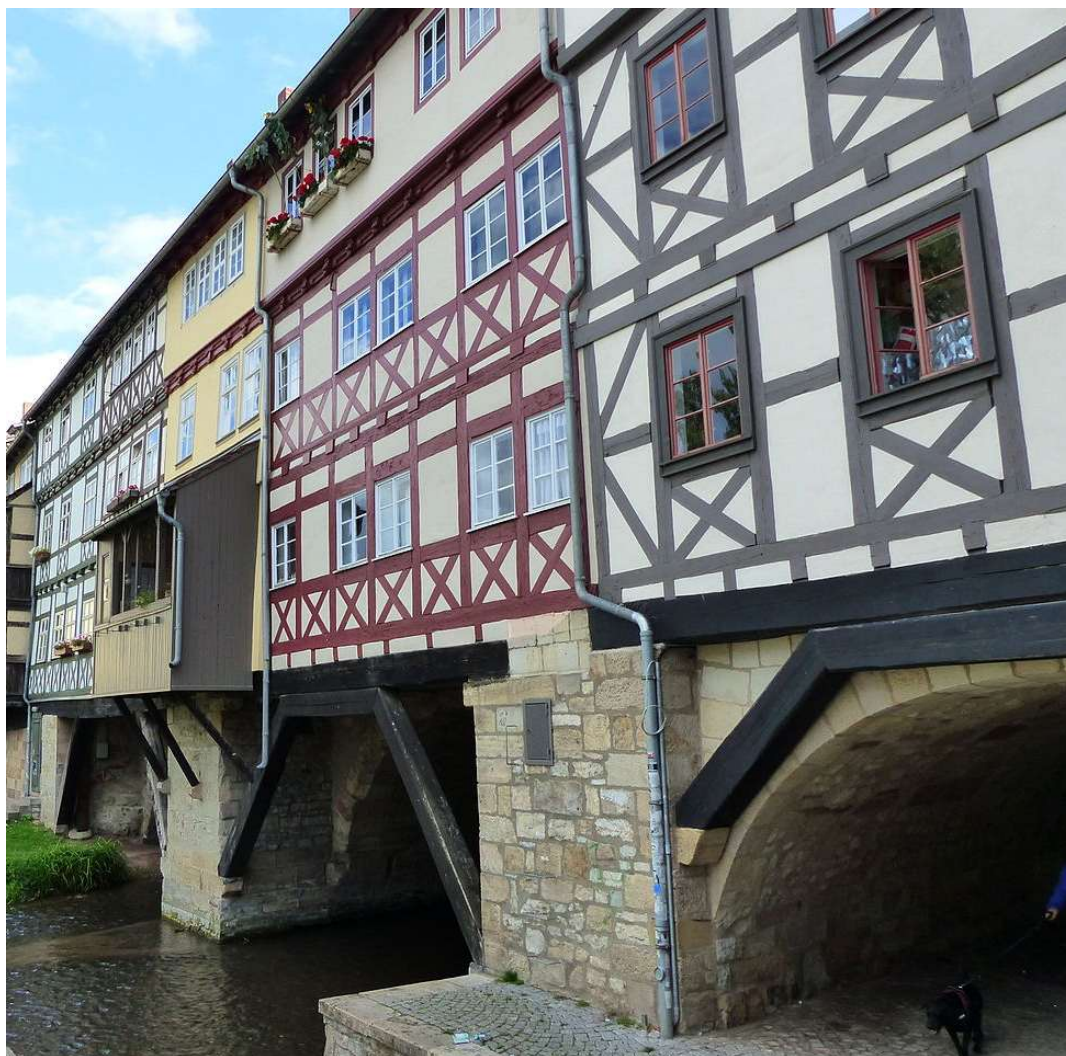
Υδρορροές σε παραδοσιακό κτίριο της Erfurt, Γερμανία, πηγή: By Dr. Bernd Gross - Own work, CC BY-SA 4.0, https://commons.wikimedia.org/w/index.php?curid=35070294
