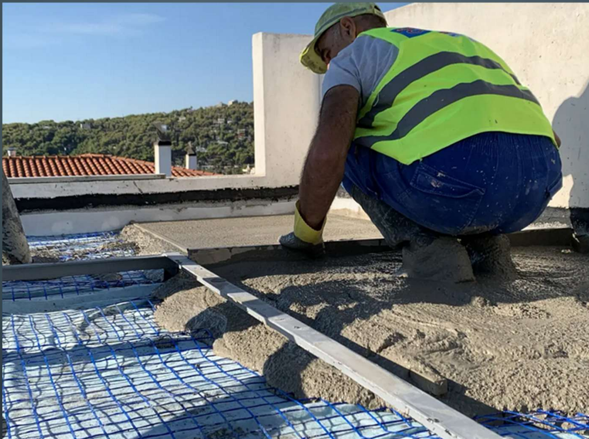
Διαμόρφωση ρύσεων με ελαφρομπετόν, πηγή: https://www.monoseisgoumas.gr/monoseis-taratson , επισκ. Οκτ. 2024
