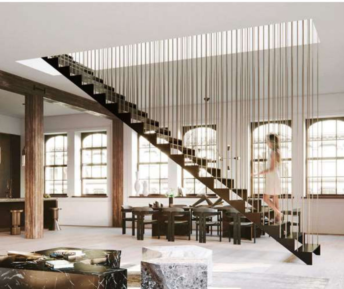
Κρεμαστή μεταλλική σκάλα, Περιοδικό Κτίριο
