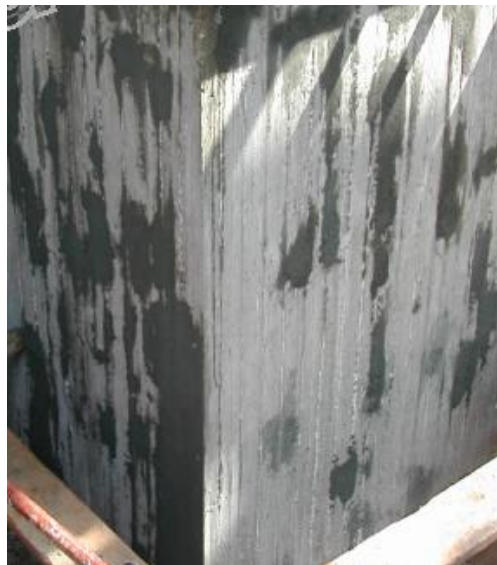
Διαδοχικά στάδια προετοιμασίας τοιχώματος υπογείου για στεγάνωση
