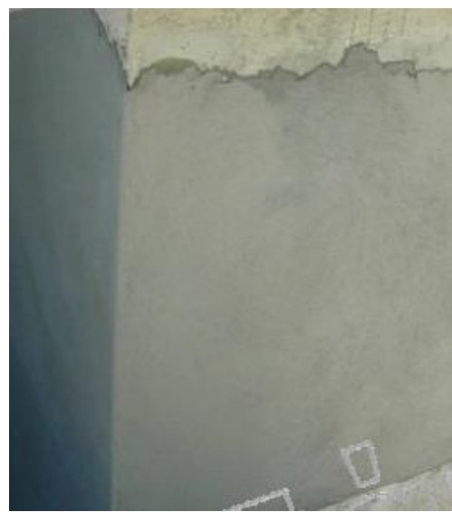
Διαδοχικά στάδια προετοιμασίας τοιχώματος υπογείου για στεγάνωση
