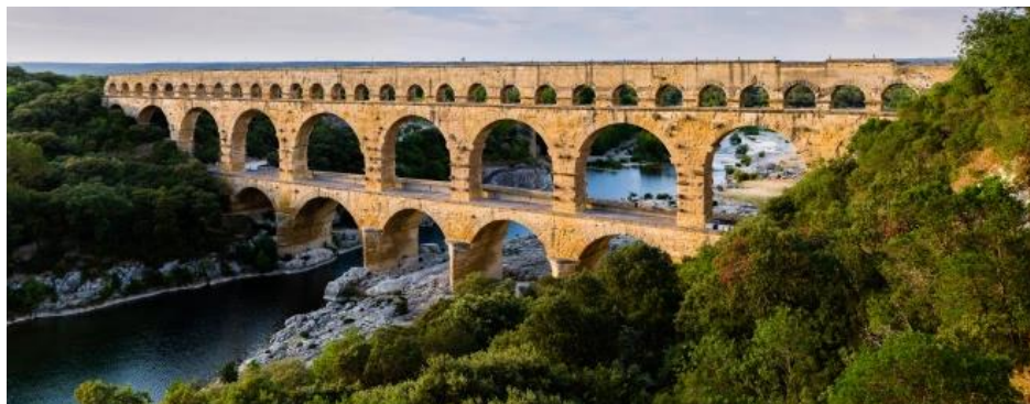
Ρωμαϊκό υδραγωγείο στην Γαλλία. Pont du Gard, 1 ος αι. μ.Χ.
