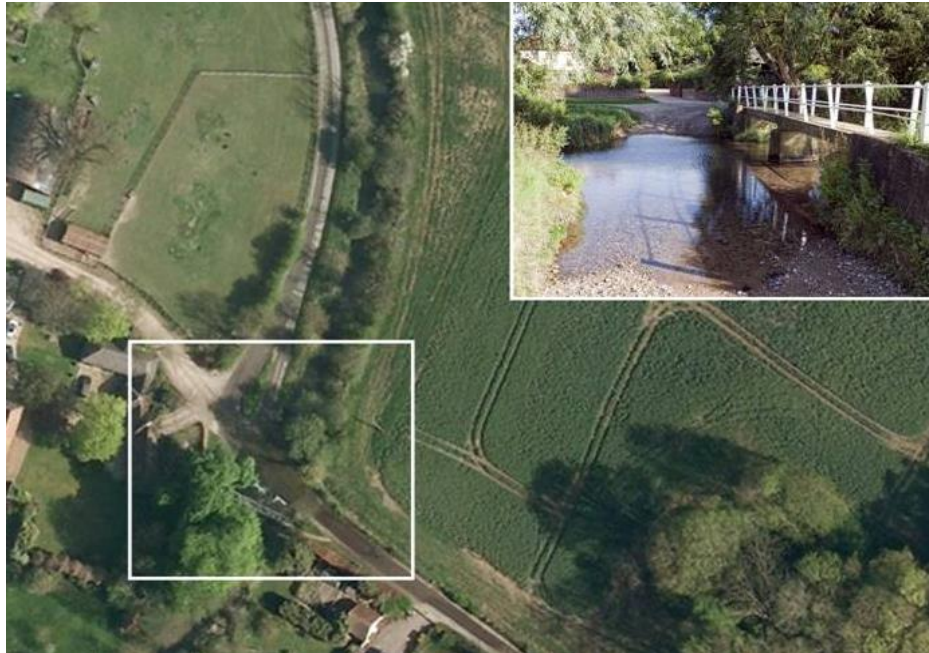
Εικόνα 33: Ρηχό "Σώμα" Νερού που Επιτρέπει τη Διέλευση, Πηγή: google. Image
