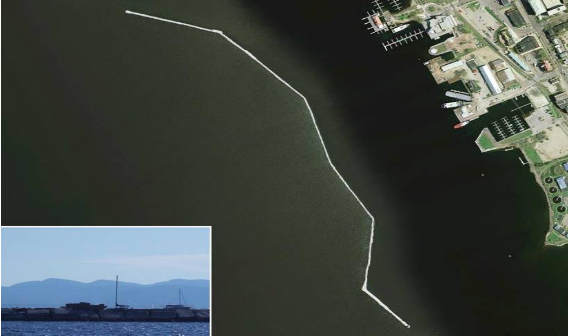
Εικόνα 120: Κυματοθραύστης, Πηγή: google. Image
