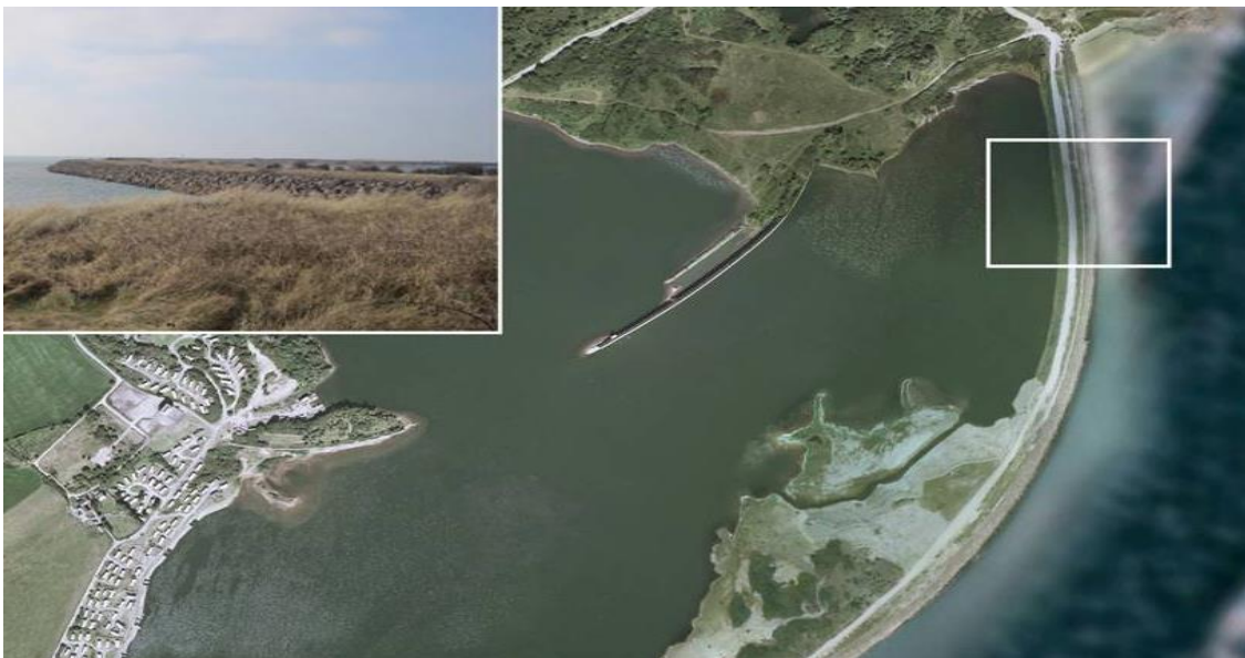
Εικόνα 119: Κυματοθραύστης, Πηγή: google. Image
