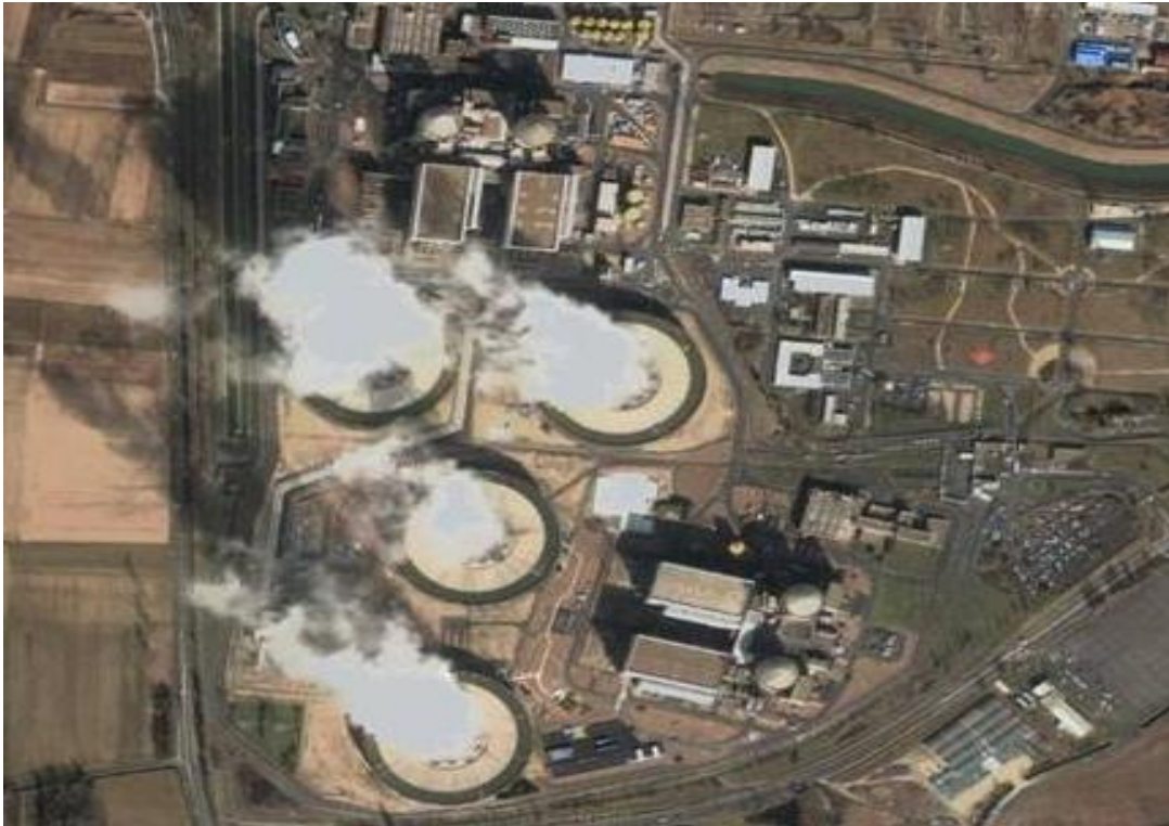
Εικόνα 103: Σταθμός Ηλεκτρικής Ενέργειας, Πηγή: google. Image
