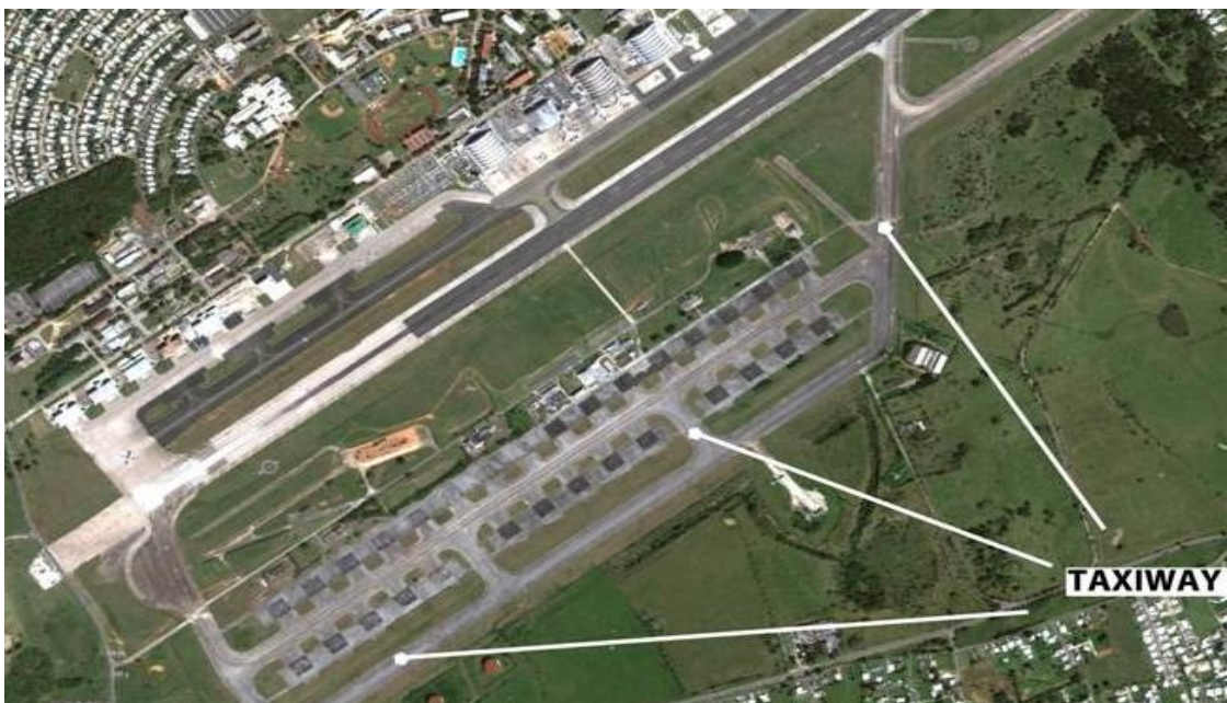
Εικόνα 132: Διάδρομος Τροχοδρόμησης, Πηγή: google. Image
