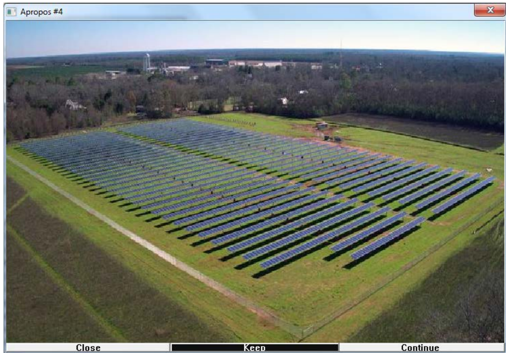
Εικόνα 18: Φωτοβολταϊκός Σταθμός Παραγωγής Ηλεκτρικής Ενέργειας
