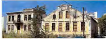
Άποψη συγκροτήματος προς την οδό 12 Αποστόλων
