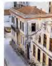
Άποψεις του κτιρίου γραφείων και της καπναποθήκης από την οδό 12 Αποστόλων.
