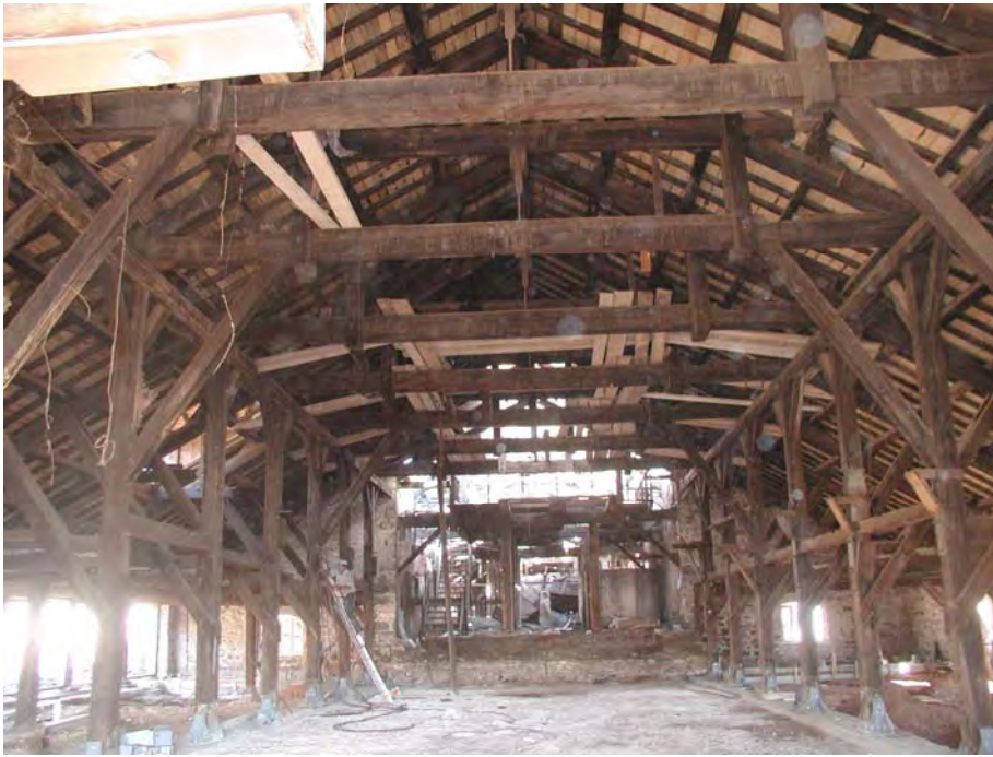
Αποθήκη Επίπλευσης (Εσωτερικός Χώρος)
