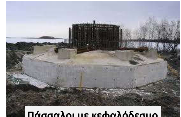
Πάσσαλοι με κεφαλόδεσμο
