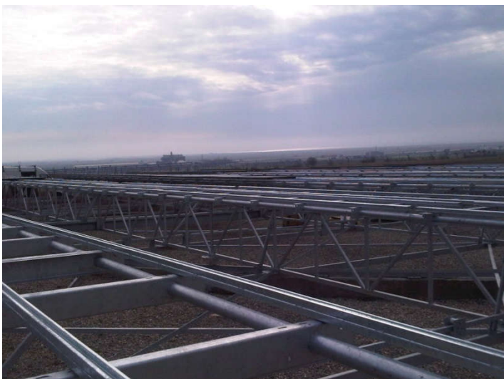
Συναρμολόγηση μεταλλικού σκελετού βάσεων
