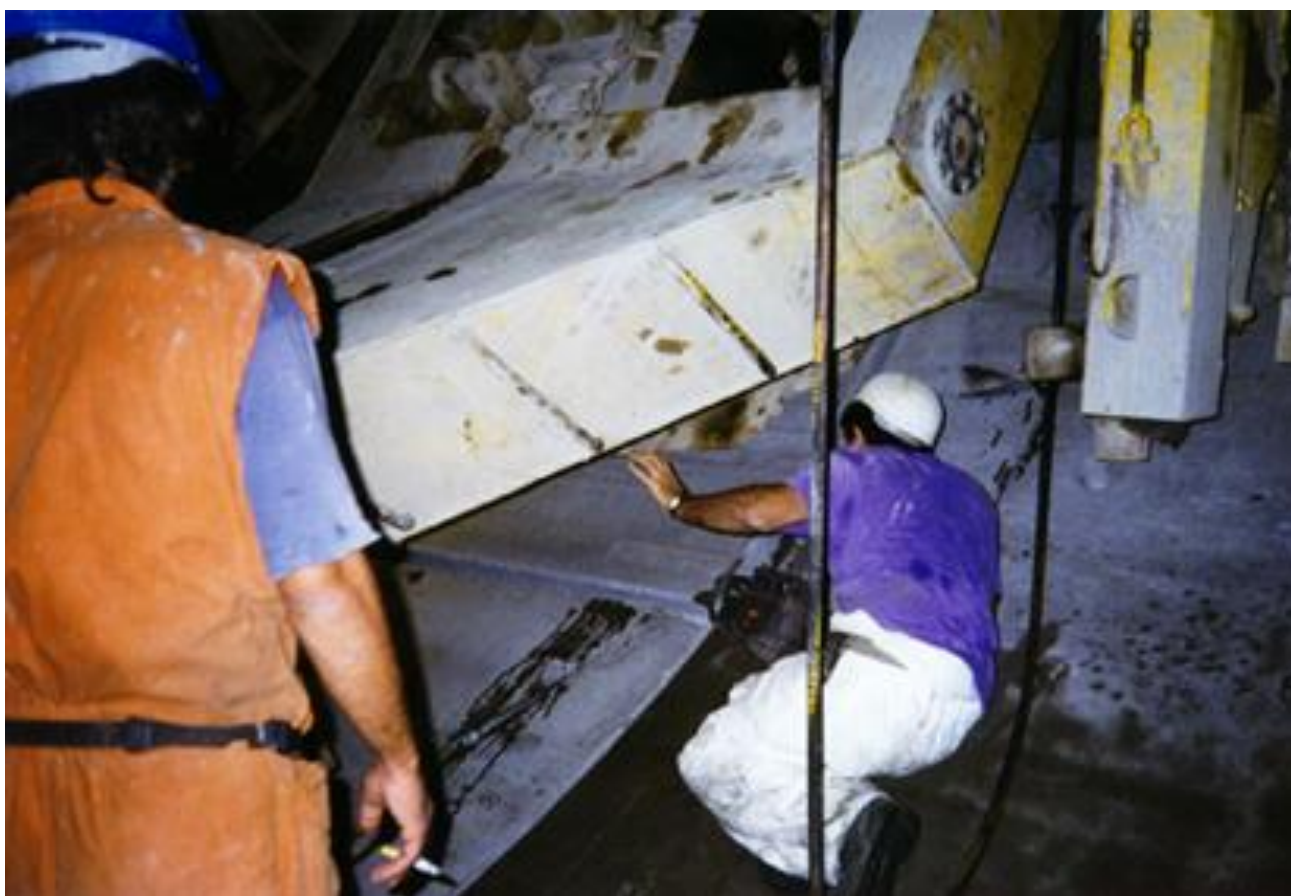
Σχήμα 10-11. Τοποθέτηση στοιχείων από τον ανυψωτήρα
