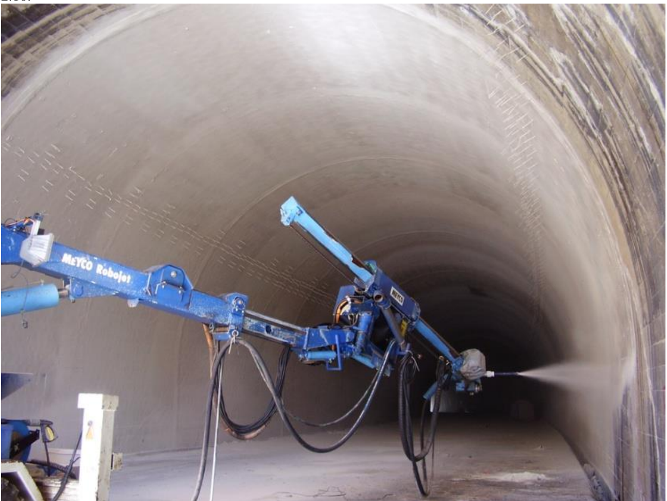
Εικόνα 12.13: Εφαρμογή κονιάματος πυροπροστασίας (Δηλαβέρης, 2004)
