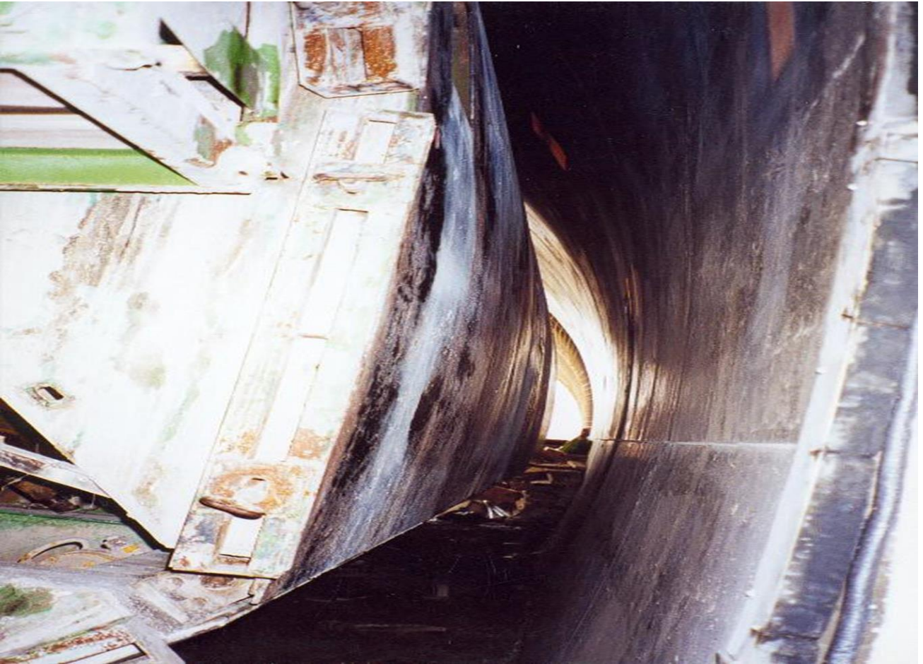
Σχήμα 8-12. Επιφάνεια σκυροδέματος μόνιμης επένδυσης μετά το ξεκαλούπωμα.
