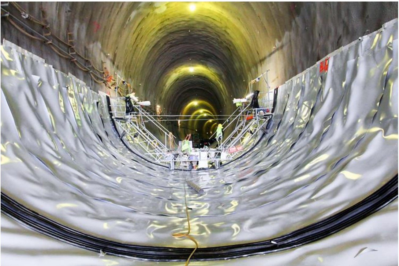
Σχήμα 9-3. Στεγάνωση του δαπέδου της σήραγγας
