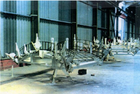
(γ) βάσεις συναρμολόγησης πλεγμάτων Σχήμα 10-1. Συνεργείο σιδηρού οπλισμού
