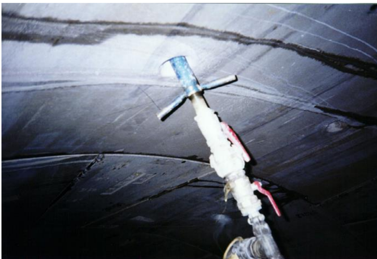
Σχήμα 10-10. Τσιμεντένεση επαφής
