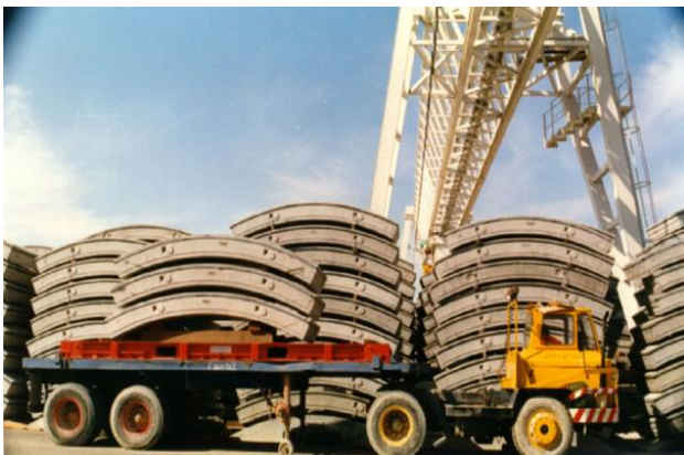
Σχήμα 10-5. Μεταφορά στοιχείων. Αριστερά: προς το εργοτάξιο. Δεξιά: προς τοποθέτηση
