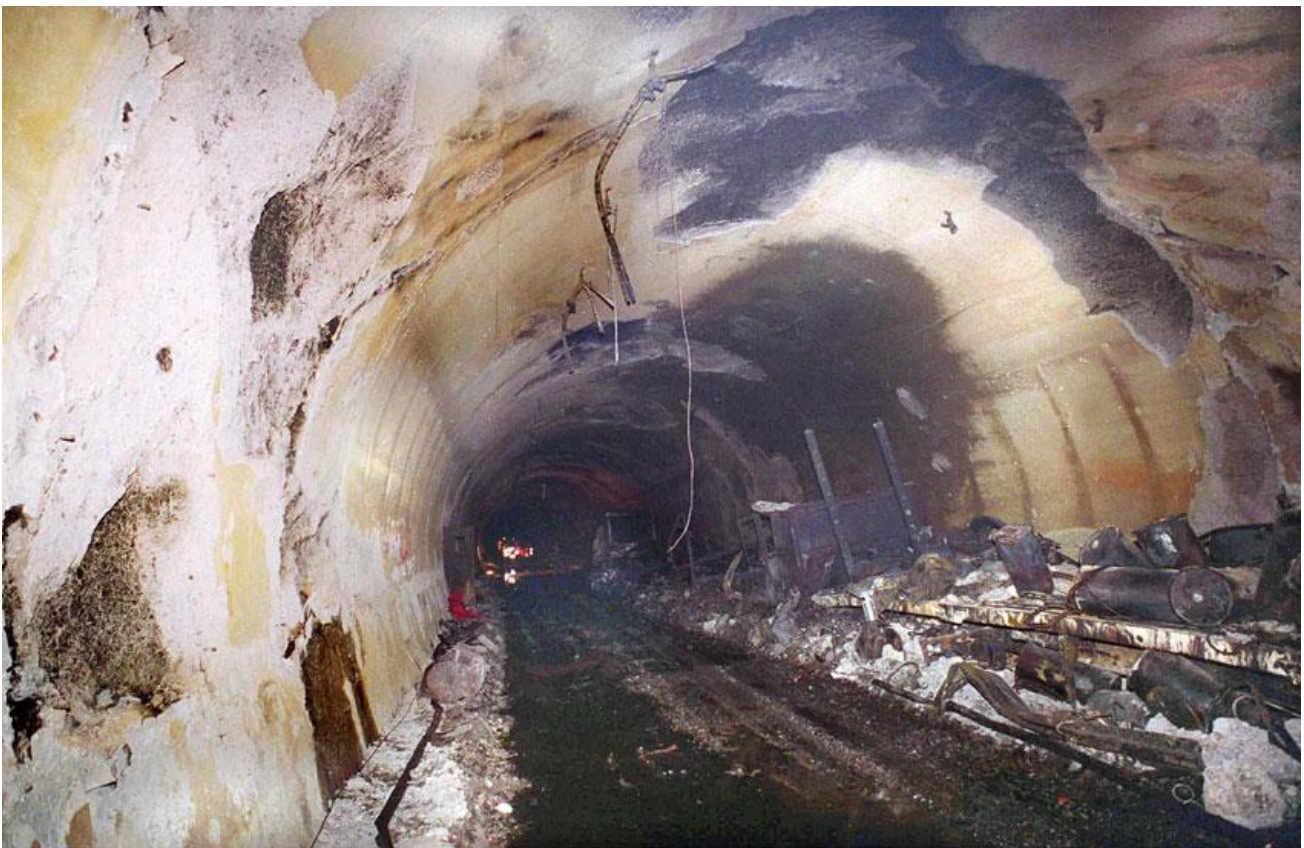
Εικόνα 12.1: Εικόνες καταστροφής της σήραγγας του Mont Blanc ( http://www.tunneltalk.com )
