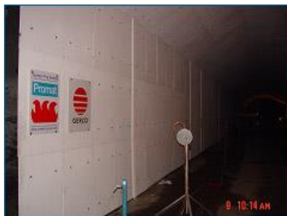
Εικόνα 12.14: Εφαρμογή πλακών πυροπροστασίας ( http://www.promat-tunnel.com )
