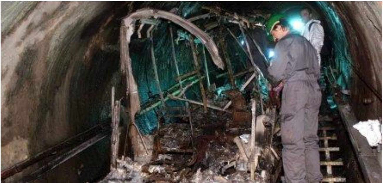
Εικόνα 12.2: Εικόνα καταστροφής της σήραγγας Καπρούν
