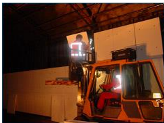
Εικόνα 12.14: Εφαρμογή πλακών πυροπροστασίας ( http://www.promat-tunnel.com )
