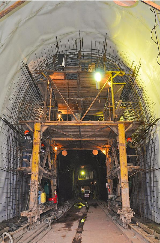
Σχήμα 8-3. Οπλισμένη διατομή σήραγγας
