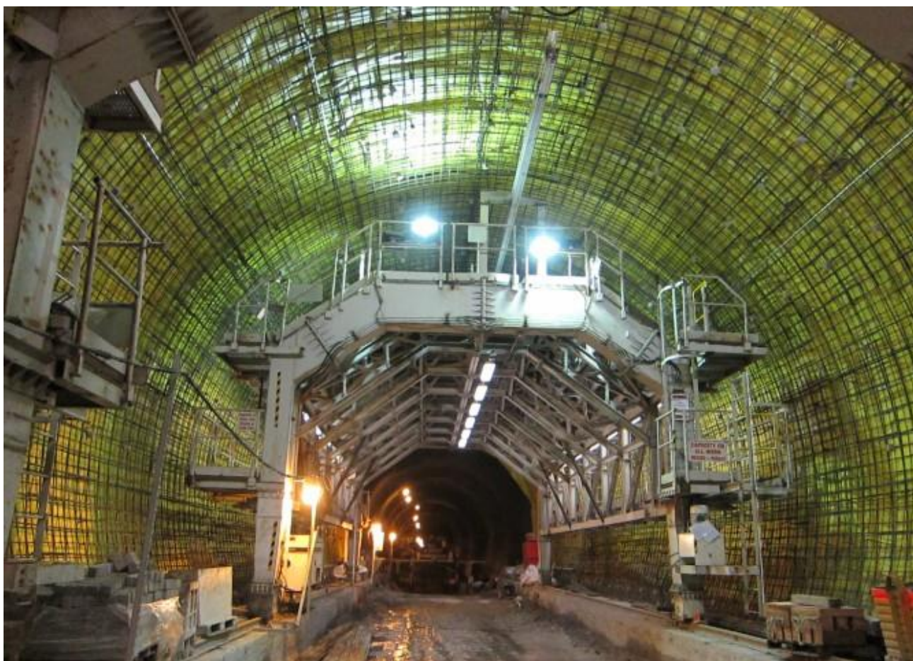
Σχήμα 8-6. Τοποθέτηση οπλισμού με τη βοήθεια ειδικού ικρίωματος.
