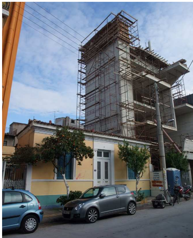
Εικ 29: Νεοανγειρόμενο κτίριο κατοικίας στο Γκάζι.
