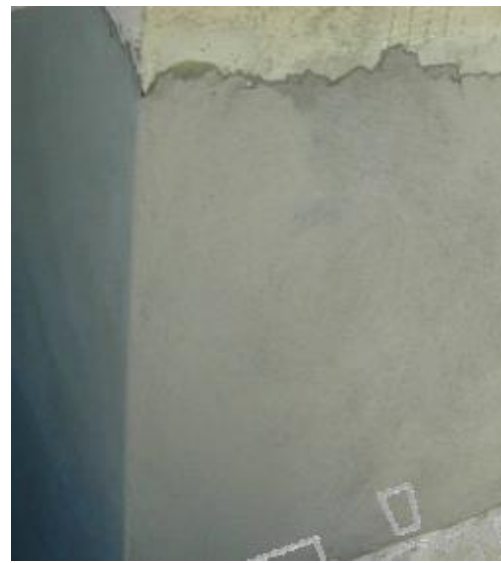
Διαδοχικά στάδια προετοιμασίας τοιχώματος υπογείου για στεγάνωση
