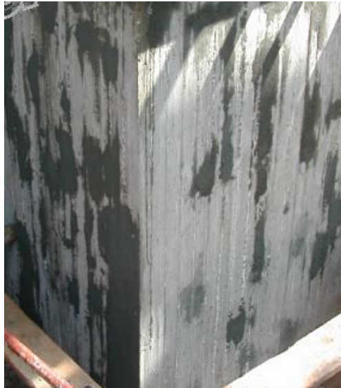
Διαδοχικά στάδια προετοιμασίας τοιχώματος υπογείου για στεγάνωση
