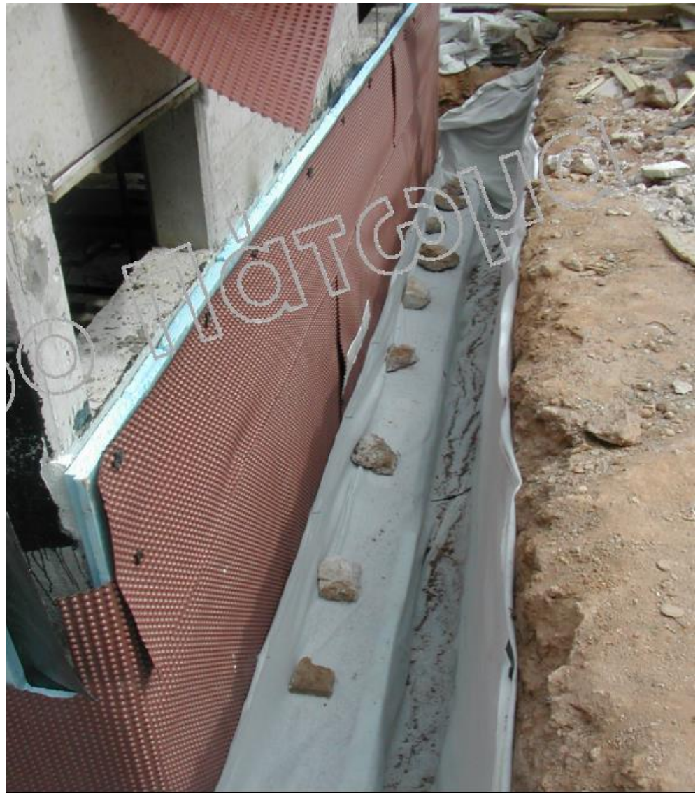
Επικάλυψη κατώτερης στάθμης και επιφάνειας σκάμματος με γεωύφασμα
