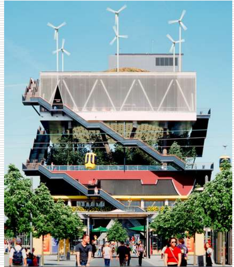
Ανεμογεννήτριες στο Περίπτερο Ολλανδίας, Expo 2000 > Ανόβερο, Γερμανία (MVRDV)
