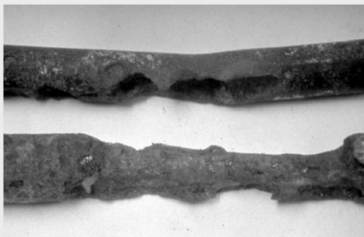
Βελονοειδής διάβρωση οπλισμού χάλυβα (5 έτη)
