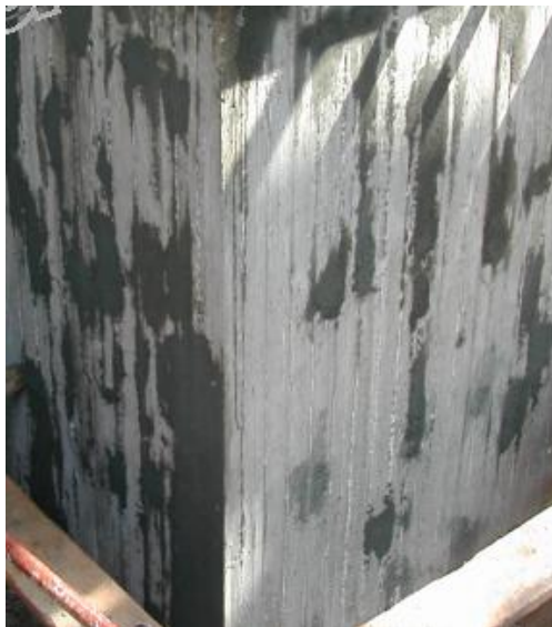
Διαδοχικά στάδια προετοιμασίας τοιχώματος υπογείου για στεγάνωση
