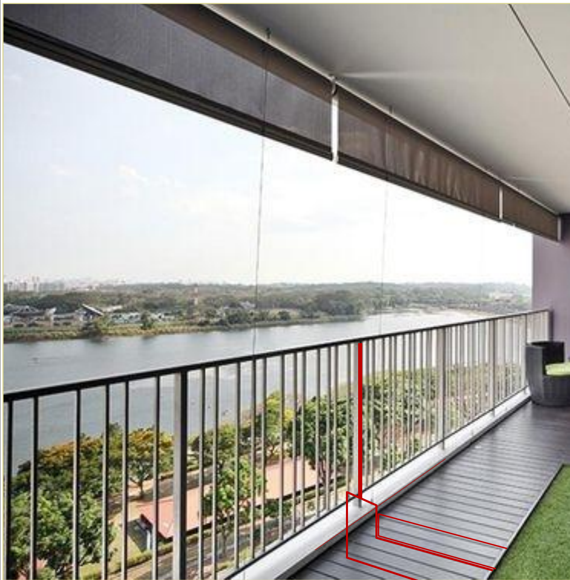
Στηθαίο αποκλειστικά με ελαφριού τύπου υλικά (κιγκλίδωμα)
