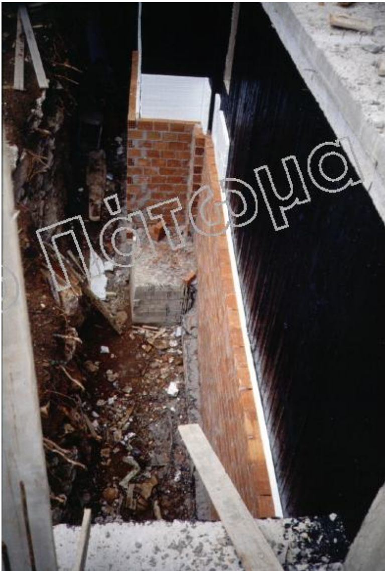
Προστασία περιμετρικών στεγανώσεων τοιχώματος με δρομικό τοίχο
