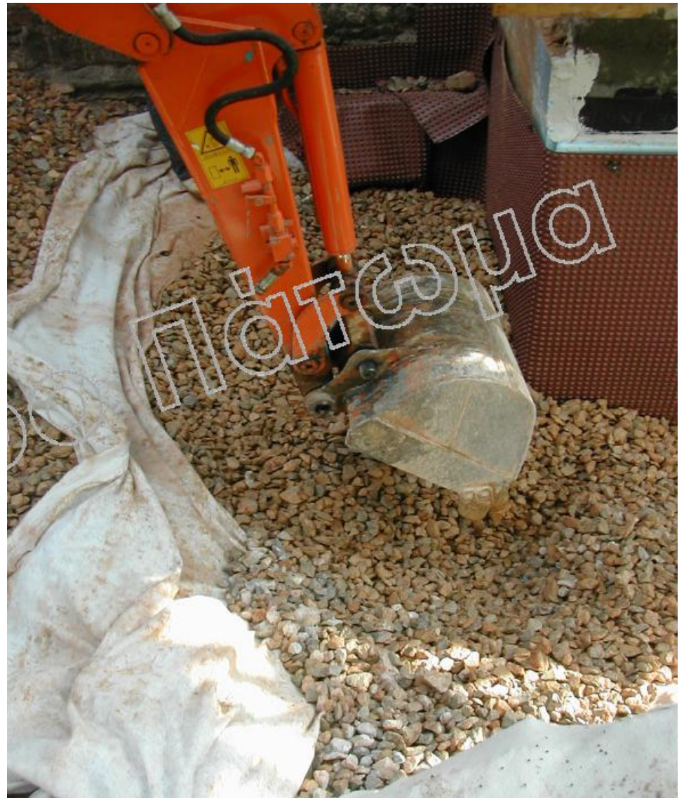
Πλήρωση (γέμισμα) κενού με διαβαθμισμένο υλικό (αποστράγγιση) > Μηχανική καταπόνηση
