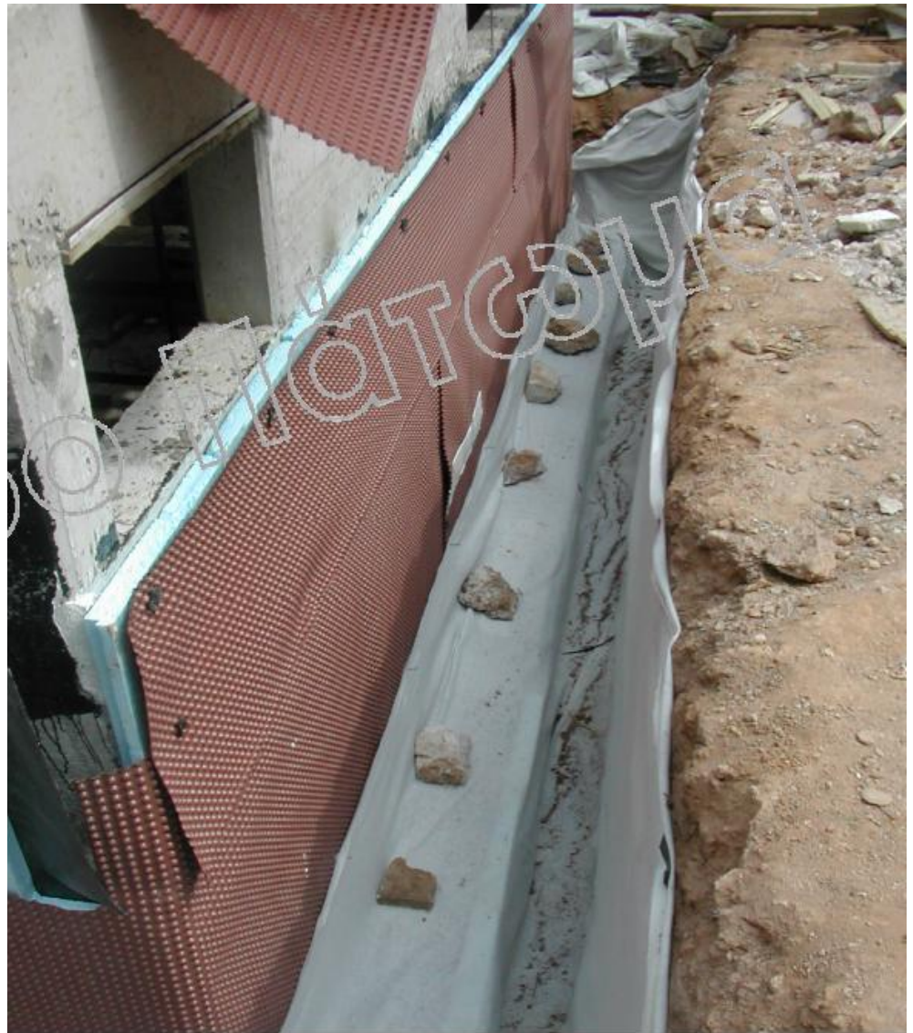
Επικάλυψη κατώτερης στάθμης και επιφάνειας σκάμματος με γεωύφασμα
