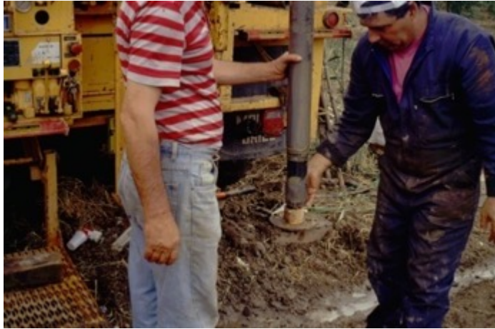
Ανέλκυση δειγματολήπτη Shelby
