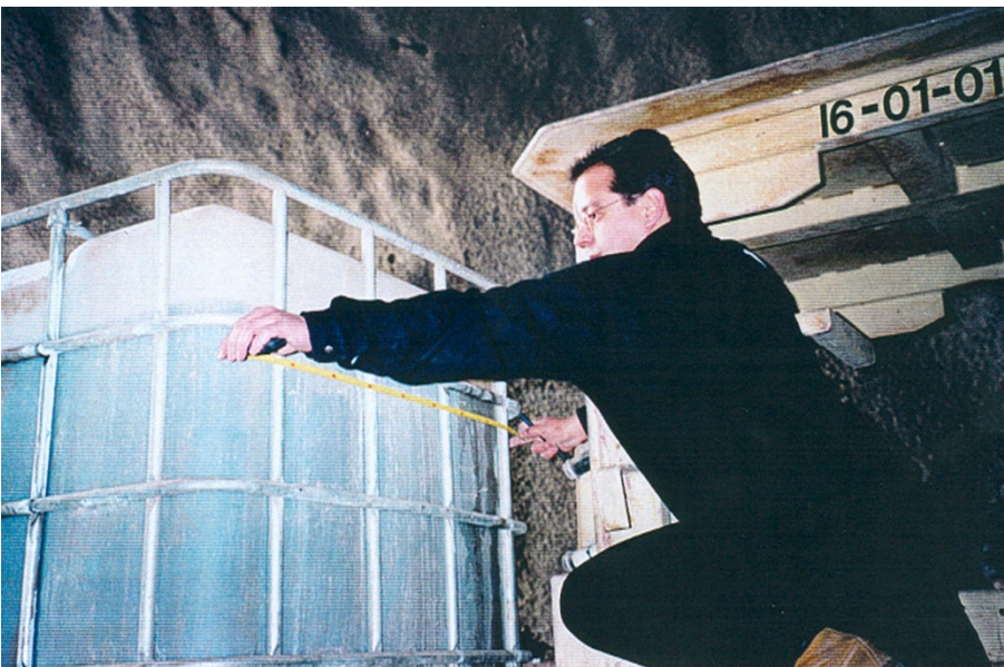
(α) Μέτρηση διαστάσεων δοχείου επιταχυντή
