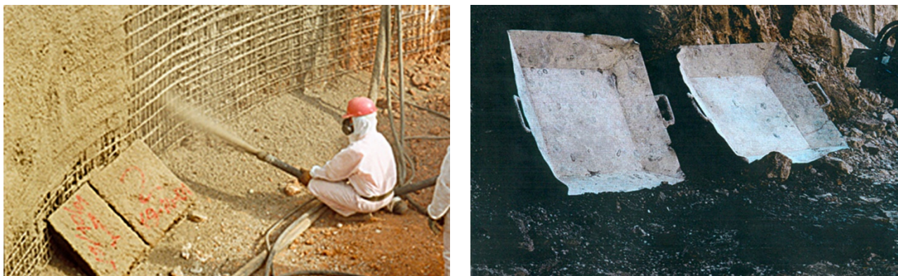
Σχήμα 4-11. Το εκτοξευμένο σκυρόδεμα ελέγχεται με τη λήψη τελάρων πάχους 15cm, ακμής εσωτερικής 60cm και εξωτερικής 80cm, τα οποία πρέπει να γεμίζουν με μία στρώση (Μιχαηλίδης & Γαρατζιώτης, 2009)
