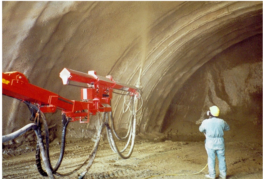
(β) Εκτόξευση με χρήση Robot
