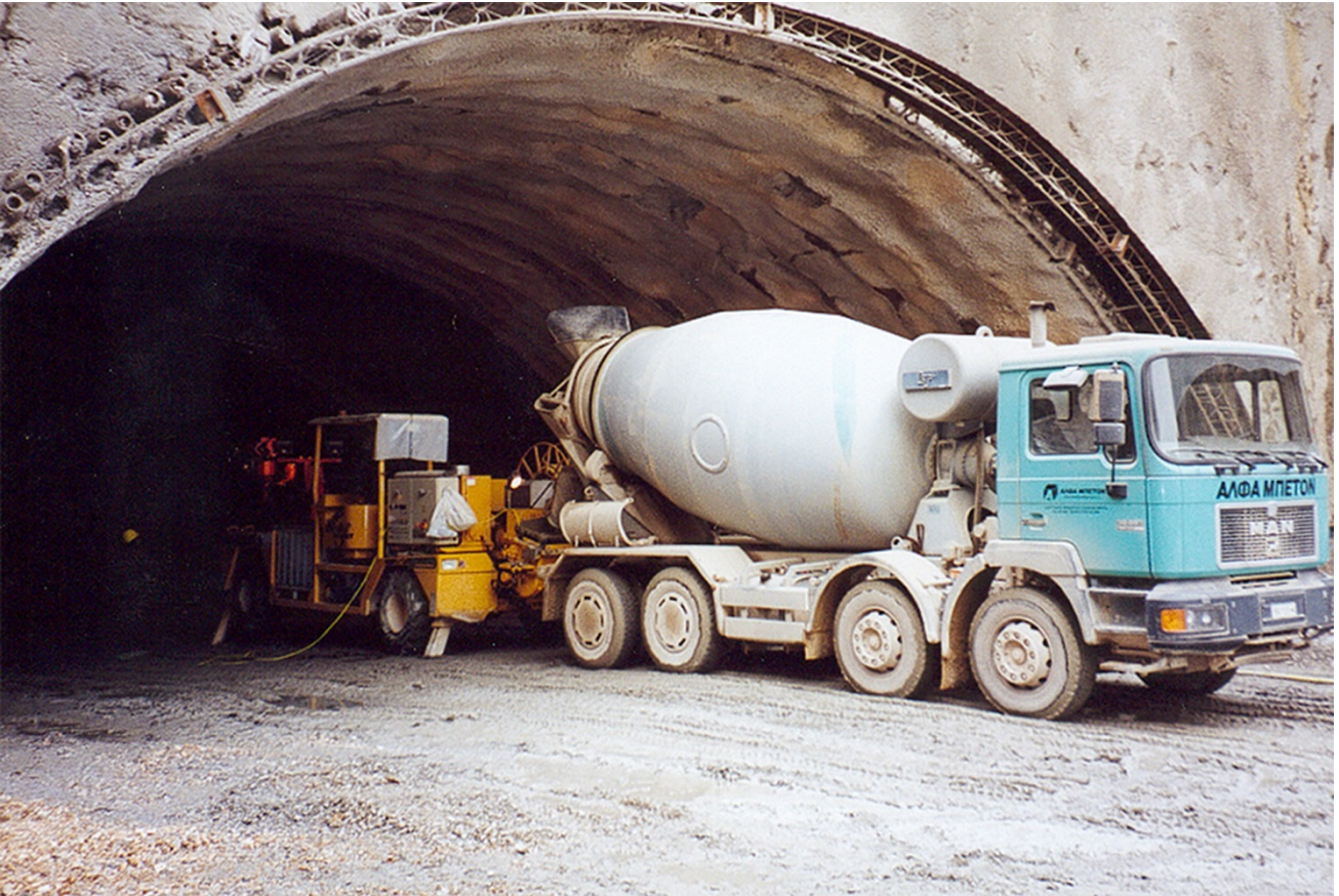
Σχήμα 4-5. Τροφοδότηση χοάνης της αντλίας (Μιχαηλίδης & Γαρατζιώτης, 2009).
