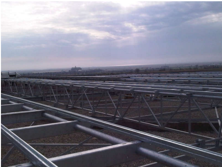
Συναρμολόγηση μεταλλικού σκελετού βάσεων
