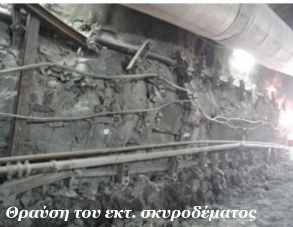
Τοπικός λυγισμός μεταλλικού πλαισίου λόγω υπερφόρτισης του κελύφους της άνω ημιδιατομής
