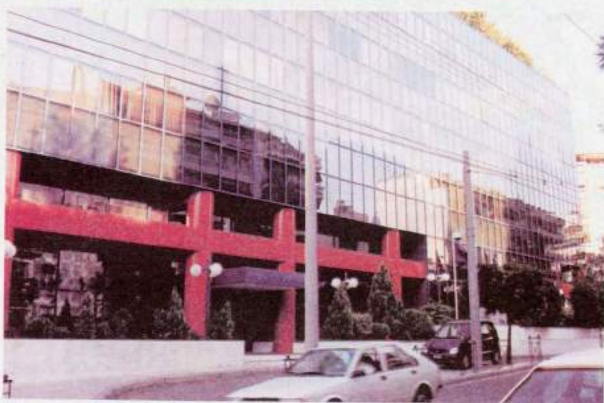
1.3. Κτίρια γραφείων, περιοχή κεντρικών λειτουργιών
