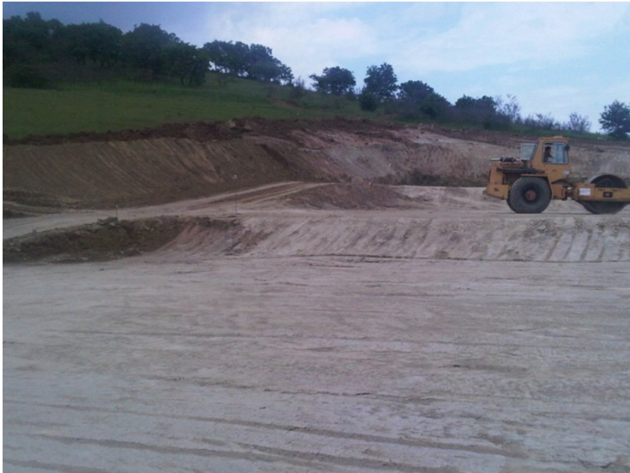
Καθαρισμός & διαμόρφωση περιβάλλοντος χώρου
