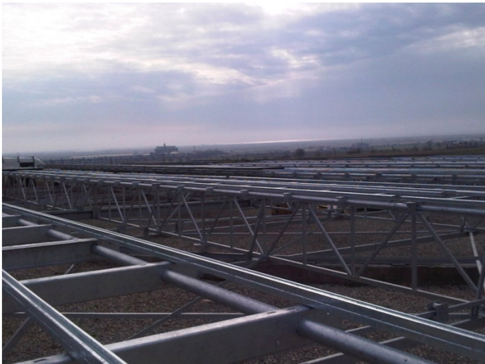
Συναρμολόγηση μεταλλικού σκελετού βάσεων
