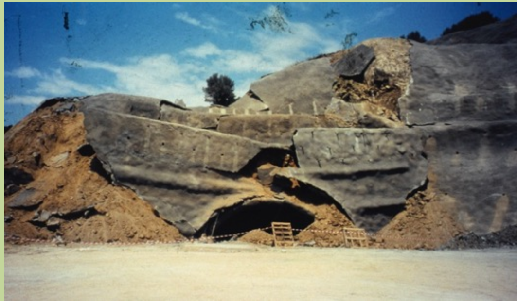
ΑΣΤΟΧΙΑ ΣΤΟΜΙΟΥ ΣΗΡΑΓΓΑΣ ΠΕΡΙΦΕΡΕΙΑΚΟΥ ΠΑΤΡΑΣ
