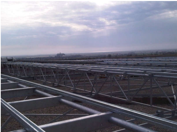
Συναρμολόγηση μεταλλικού σκελετού βάσεων
